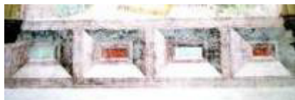
Lübeck, Burgkirche, Sakristei, unterer Wandbereich, 2. H. 16. Jh., später als die Malerei oberhalb
