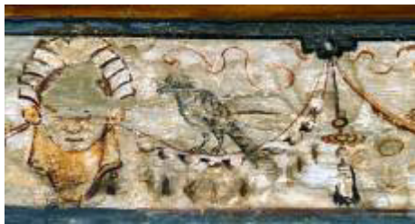
Lübeck, An der Untertrave 96, Wand unterhalb der Decke, 1606
