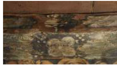
Lübeck, Engelsgrube 45, Seitenflügel, Deckenbalken von der Seite u. unten, 1660-80
