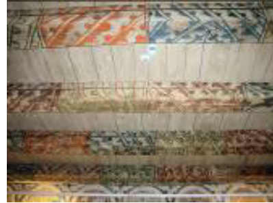
Thorn/Torun, Breite Str./ul. Szeroka 22, Deckenbalken
