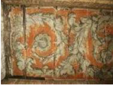
Lübeck, Glockengießerstr. 26, Seitenflügel, Holzbalkendecke,
