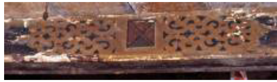
Lübeck, Fischergrube 16, Seitenflügel, Deckenbalken, 1585-1615
