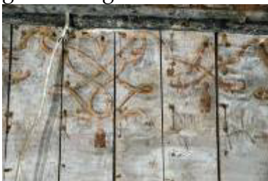
Lübeck, Böttcherstr. 8, Bretterwand,
