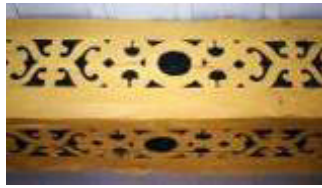
Lübeck, Kapitelstr. 5, Deckenbalken, 1570-1600
