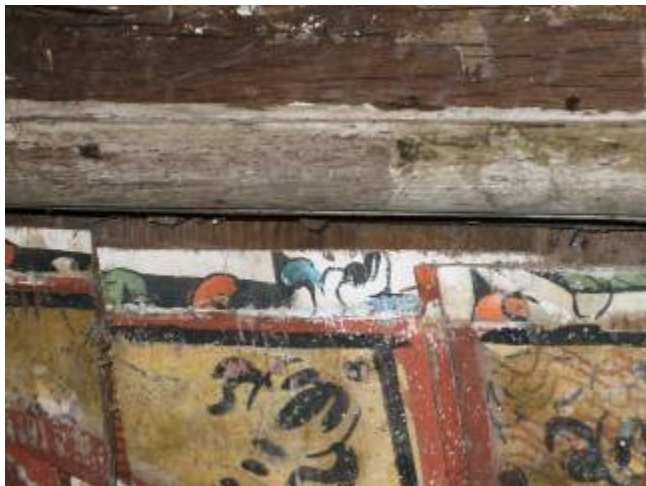
Abb. 13 Große Burgstr. 2: Torhaus des ehemaligen Marsstallkomplexes. 1612 wurde die farbenfrohe spätgotische Deckenmalerei, entstanden um 1500 (oben) mit dezenter ockergrundigen Mauresken (unten) übermalt.
