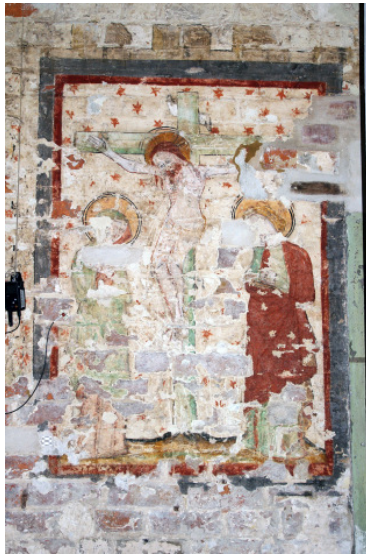
Große Gröpelgrube 8, ehem. Pilgerhalle, Kreuzigung um 1370 (Foto: Braca 2010)
