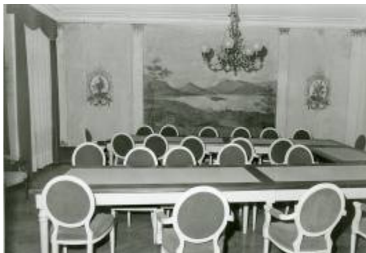
Abb. 21 Bel Etage in der Beckergrube 16
