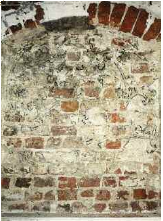
13 Mengstraße 64, spätgotische Ranken (Foto: D. Oldenburg © Denkmalpflege HL)
