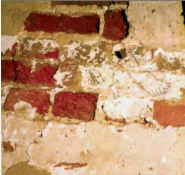
*Abb.14: Verlust einer figürlichen Wandmalerei des 15. Jahrhunderts: Die Salze haben die Tüncheschichten der Wandmalerei und die darunter liegenden Backsteinoberflächen zerstört, sichtbar nur noch ein Fuß*
