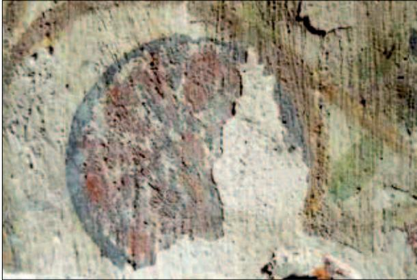
*Abb. 16: Salzschaaden an einer gotischen Rankenmalerei mit abgelöster und abgefallener Malschicht*
