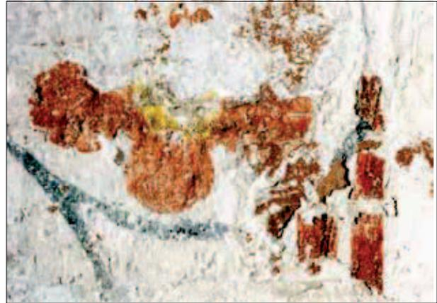
*Abb.1: Wandmalerei mit Salzscha-den (Fragment einer Blüte), Verlust der Malschicht, im Bereich der gemalten Fugen (rechts) sind die Malschichten sogar bis zur Backsteinoberfläche abgesprengt*
