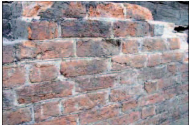
*Abb.5: Backsteinmauerwerk des 13. Jahrhunderts mit gotischem Verband aus zwei Läufern, einem Binder und Fugenstrich (Dachfuge)*
