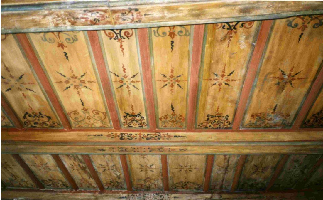
Große Petersgrube 23, Seitenflügel, Obergeschoss
