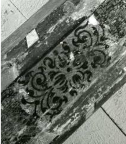
Engelsgrube 47, Seitenflügel Erdgeschoss
