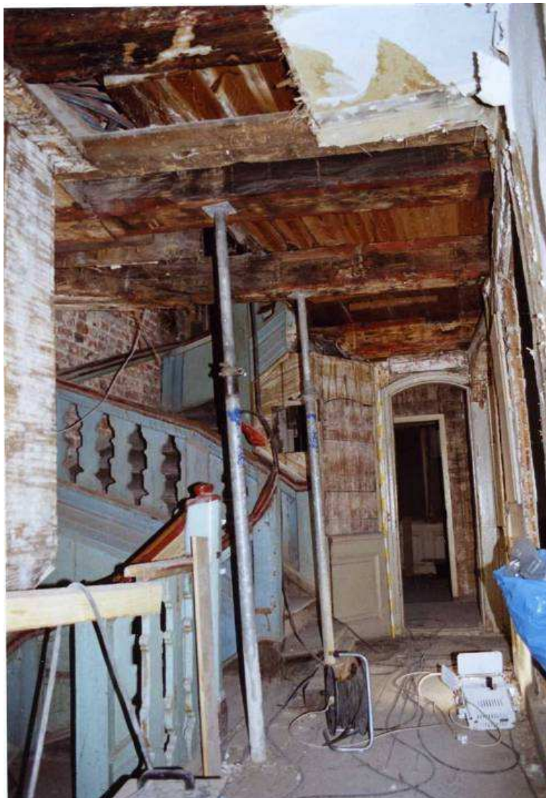
Typische Bausstellensituation: nach Abnahme der modernen Decke wird die historische Deckenmalerei sichtbar
